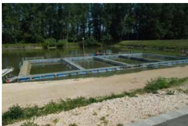
Védőkorlátok hiánya a haltárolónál és a hozzá vezető bejárónál
