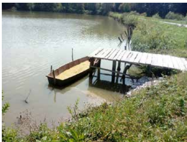
A mólón hiányzik a feljáró és a korlát a biztonságos be- és kiszálláshoz
