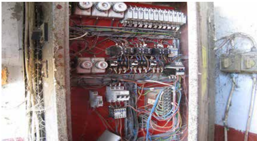
Ajtó nélküli 400V-os villamos kapcsolószekrény – a villamosan aktív részek kézzel érinthetőek
