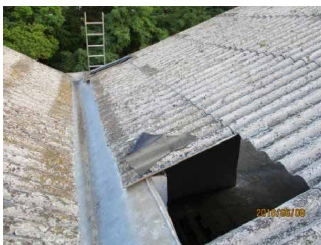
A feljáró létra, a közlekedésre igénybe vett vápacsatorna, és a beszakadt hullámpala
